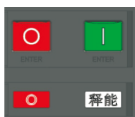
断路器断开且无储能状态
